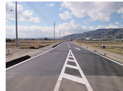
▲安全確保のために既存の町道を修繕
