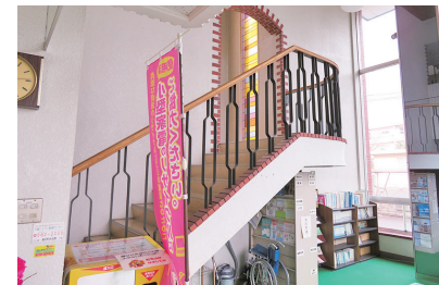
▲階段手すりを改修予定
