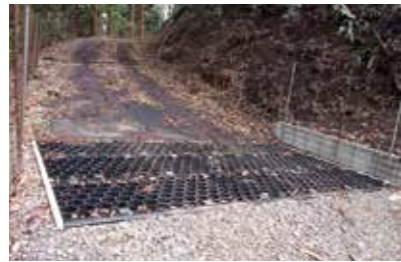
▲道路からの侵入を防ぐグレーチングを設置
