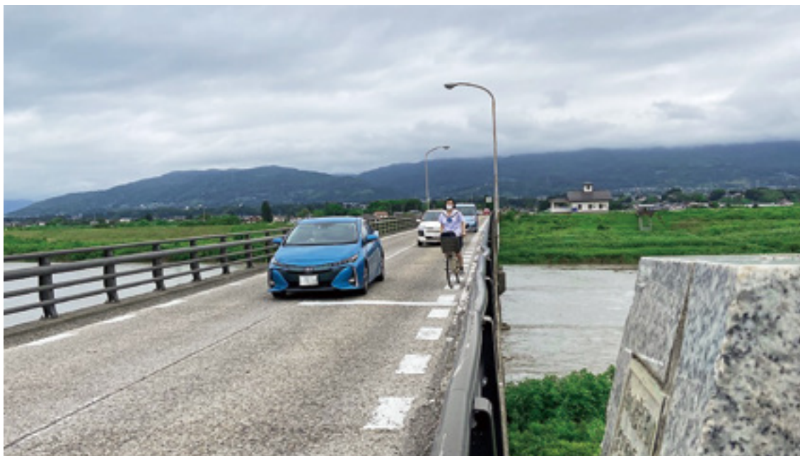
通学時の安全性確保が急がれる伊達崎橋(令和3年8月)
