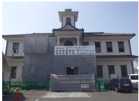
■写真 東日本大震災被害修理中の旧伊達郡役所
