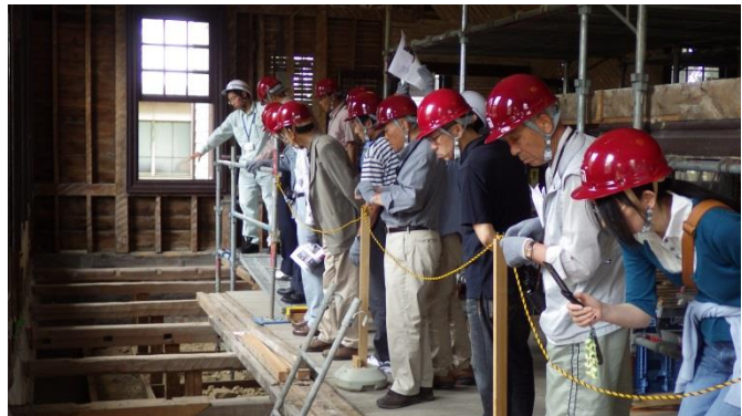
■写真 旧伊達郡役所修理事業現場見学会
