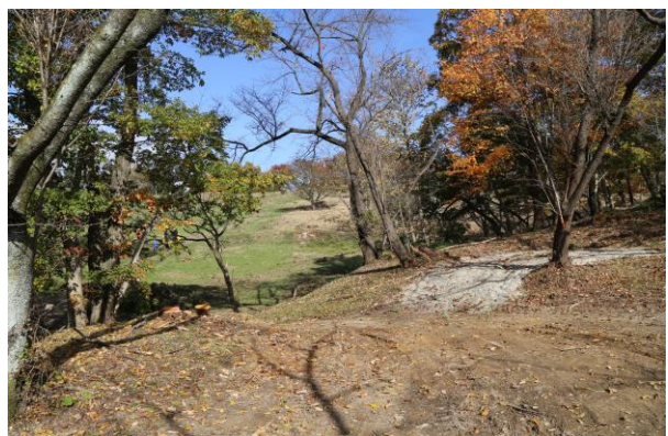
老朽化トイレ 撤去後
