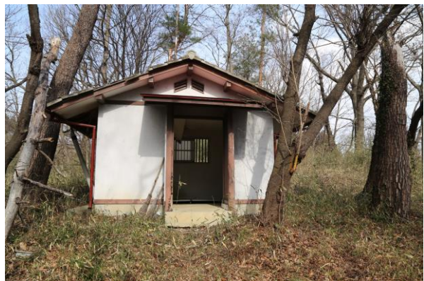
老朽化トイレ 撤去前
