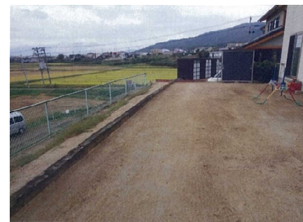
完成 抑止杭工
