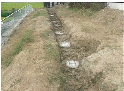
施工状況 抑止杭工
