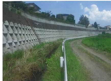
完成 地山補強土
