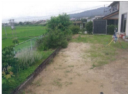
着手前 抑止杭工
