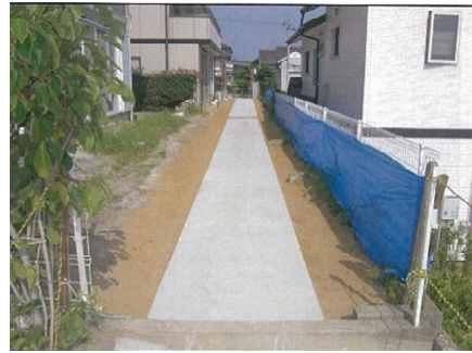
完成 EPルートパイル工
