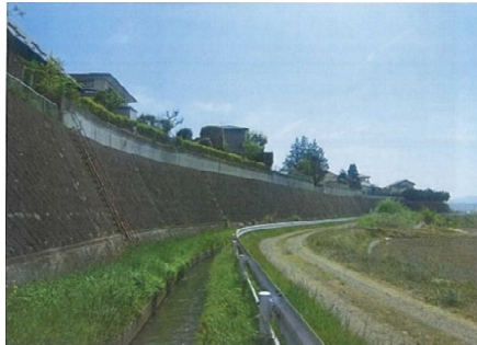
着手前 地山補強土工
