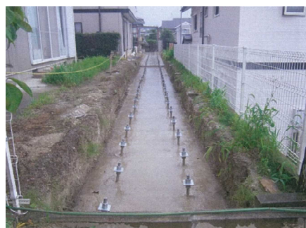
施工状況 EPルートパイル工
