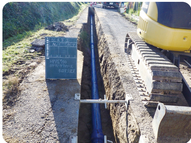
水道管布設替 耐震管に
