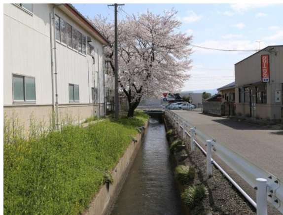
■写真 西根上堰 西根堰が三面コンクリートになっている。
