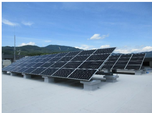
役場庁舎屋上に設置されている太陽光発電パネル
