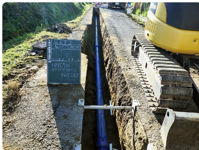
安全で安心な水の安定供給のための配水管布設工事
