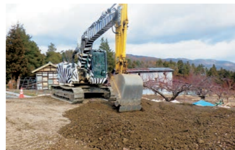
生活道路の拡幅工事
